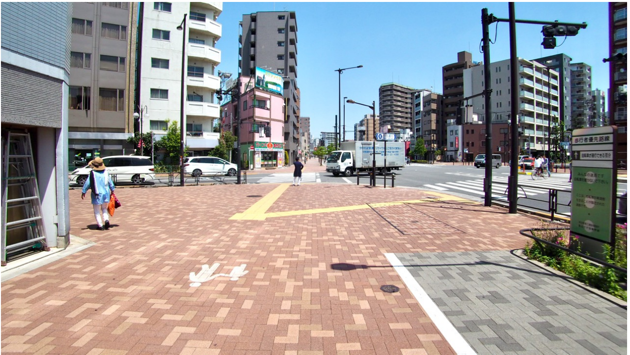
都道317号の南長崎一丁目交差点。潤沢な空間資源を擁しているが自転車通行空間(灰色部分)を交差点手前で打ち切っている。(2016年5月に筆者が撮影)
