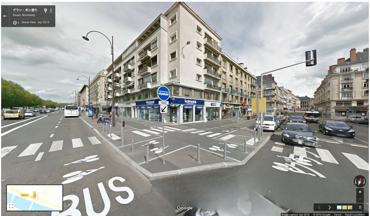
フランス、ルワンのRue Grand PontとQuai de la Bourseの交差点。双方方向通行の自転車道同士を単純に直交させている。車道からのオフセットが信号待ちの自転車の滞留空間を生み、交差方向の自転車の流れが妨げられにくくなっている。 出典：Google Maps Street View (2015-04@49.4382756,1.0919125)
