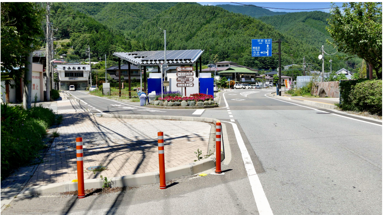
富士河口湖町長浜の山梨県道710号。交差点内に張り出す形で縁石を新設し、鋭角だった交差角度を直角に変更している。改良前は左の枝が抜け道に使われており、手前の道路から高速で左折する車が見られた。2016年7月に筆者が撮影。
