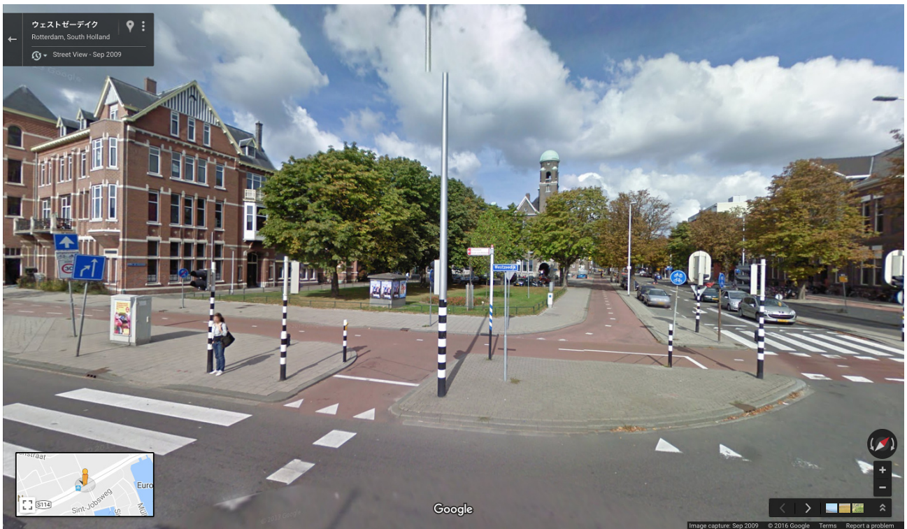
オランダ、ロッテルダムの Westzeedijk と Pieter de Hoochweg の交差点。 双方方向通行の自転車道2本がT字型に接続し、そこに一方通行の自転車横断帯 (画面手前) を繋げている。 出典：Google Maps Street View (2009-09@51.9055124,4.4602699)
