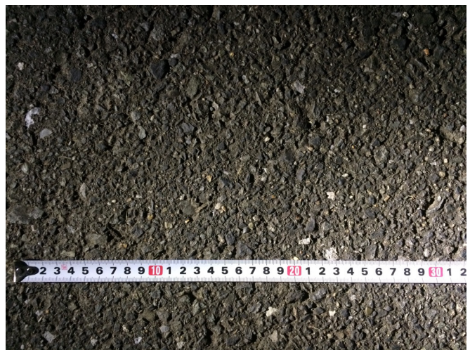
実験場所の舗装状態
