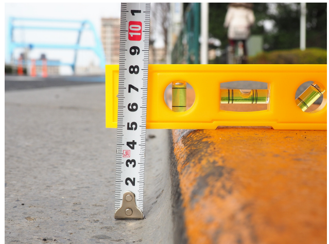
転倒事故発生地点の縁石の高さは改定ガイドラインの基準と同じ5cmである。2017年2月に筆者が撮影。
