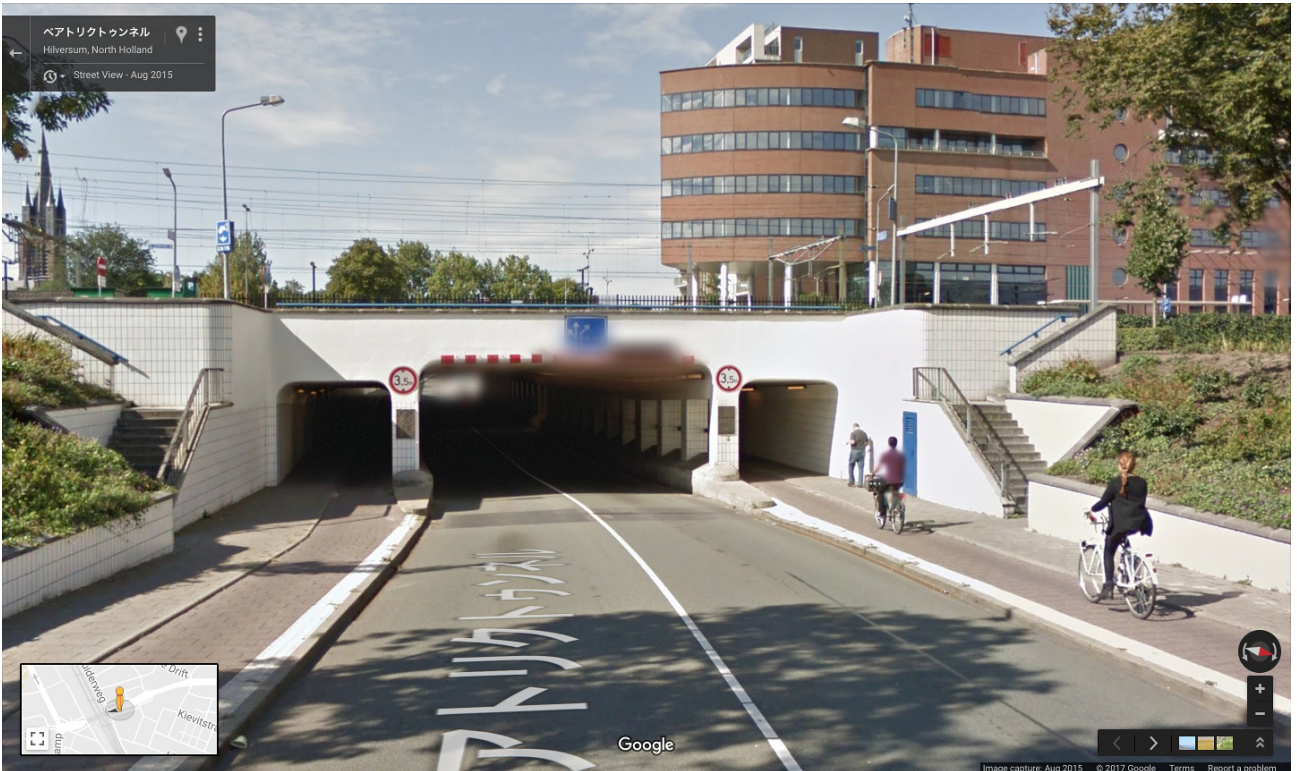
同駅南のアンダーパス。ここでも歩道と自転車道（一方通行）が構造的に分離されている。 道路左右の法面は斜度が緩く、圧迫感を抑えている。出典：Google Maps Street View (2015-08@52.2248264,5.1842318)
