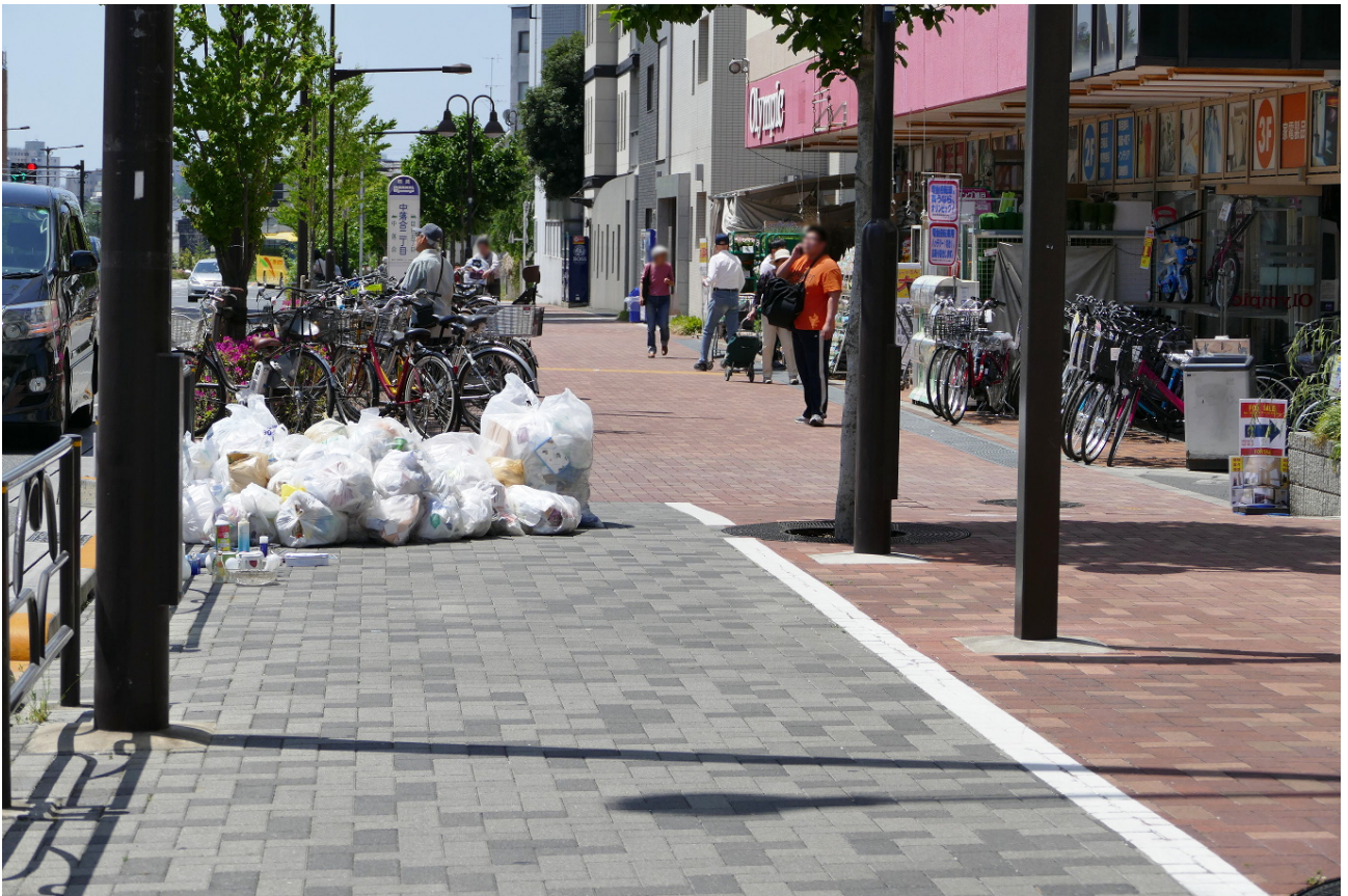
都道317号の中落合の自転車歩行者道。ゴミ集積やスーパー来店客の駐輪需要を考慮せず空間配分した為、自転車通行空間が塞がっている。更に画面奥にはバス停の乗降空間も有るので自転車通行空間がその手前で打ち切られている。2016年5月に筆者が撮影。
