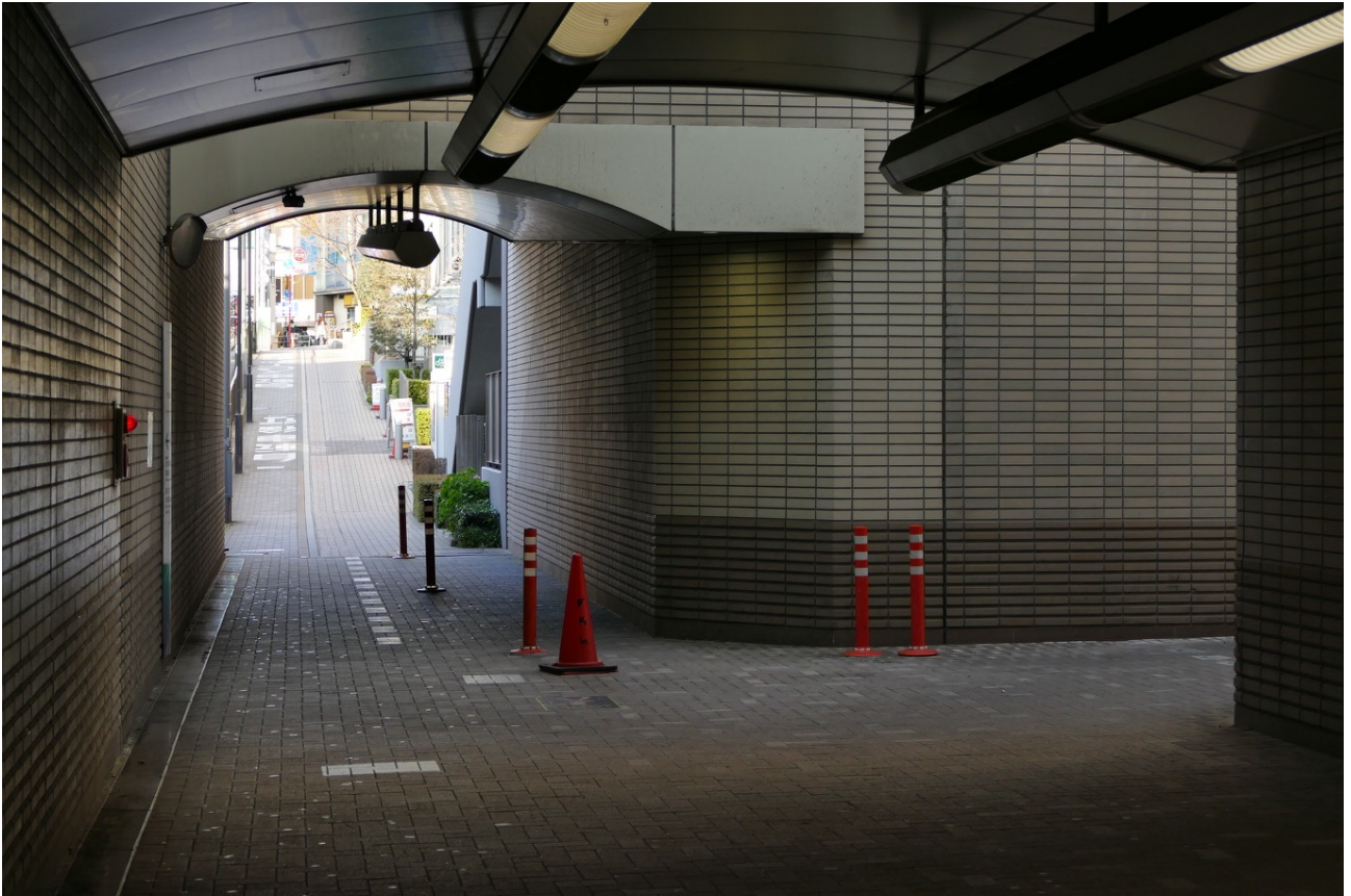
地下通路内に交差点が有り、死角が生じている。ここで出会い頭衝突が起こりやすい事がポラードと三角コーンの配置から窺える。 撮影日・場所は同上。
