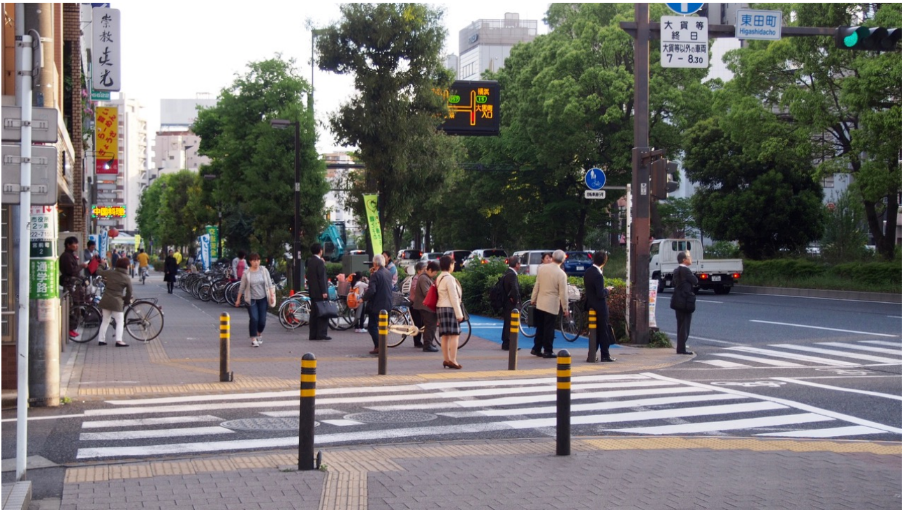
国道15号の東田町の自転車歩行者道。自転車通行空間(青色にペイントされている部分)の延長線上が信号待ちの歩行者・自転車と空間競合を起こしている。上2枚とも2015年5月に筆者が撮影。
