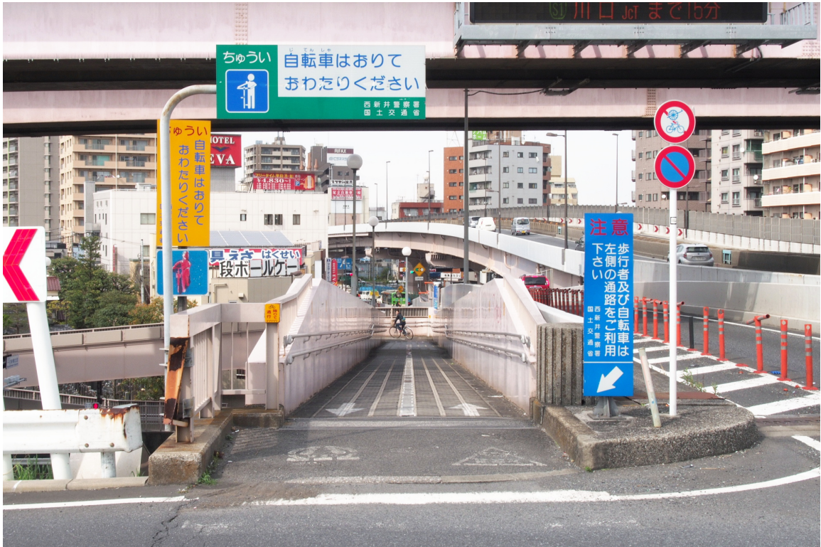
国道4号の千住新橋北側のアプローチ。急勾配で幅員が狭いにも関わらず、階段ではなくスロープを採用している。また、90度、180度の屈曲が有って見通しが極めて悪く、出会い頭事故の危険性が高い。2015年4月に筆者が撮影。
