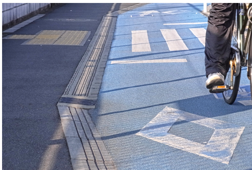
三鷹市のかえで通り。自転車道の幅員が2mを割り込むバス停周辺に限ってスロープ断面の縁石を採用し、自転車利用者が正面衝突の回避などで一時的に歩道に上がれるようにしている。2014年2月に筆者撮影。
