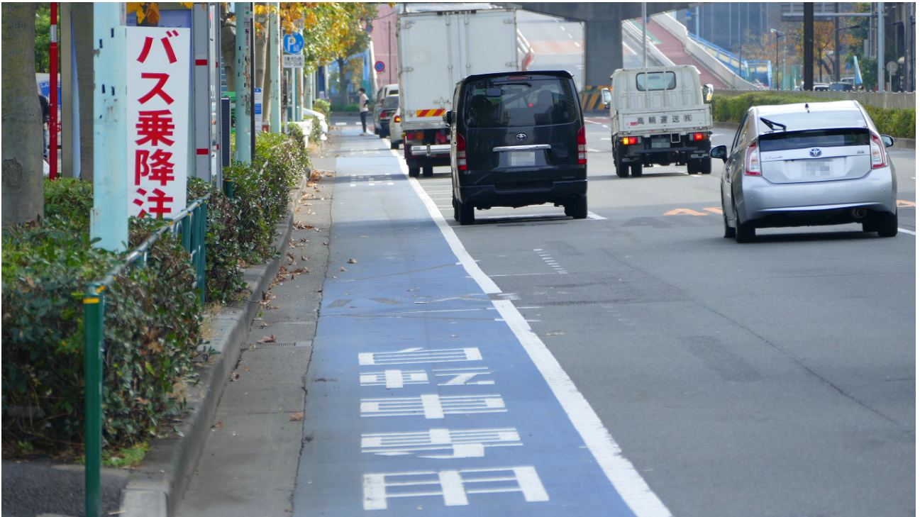
自転車レーンと駐車枠を隣接させた配置。青色ペイント部分は約 1.5 m と標準的な幅員が確保されているが……
