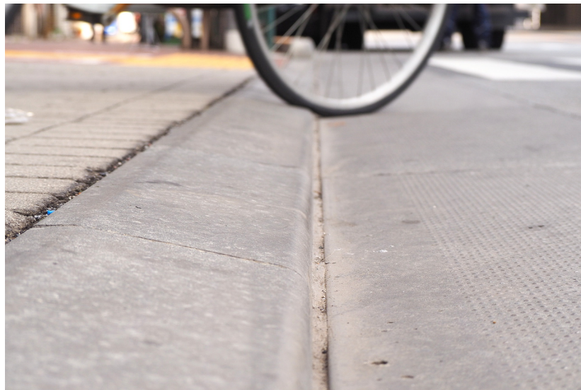
failproof な縁石形状の例。都道306号の新三河島駅付近で2017年2月に筆者が撮影。
