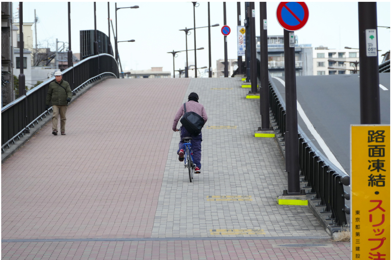
都道317号の西武新宿線陸橋。自転車通行空間(灰色)の中に街路灯の柱を収容したが為、衝突防止に柱の基部を蛍光色で強調する必要が生じ、景観の視覚的乱雑さを増している。この問題は、自転車通行空間から構造的に区別された緩衝帯に柵や柱を収容していれば防げた。2017年1月に筆者が撮影。
