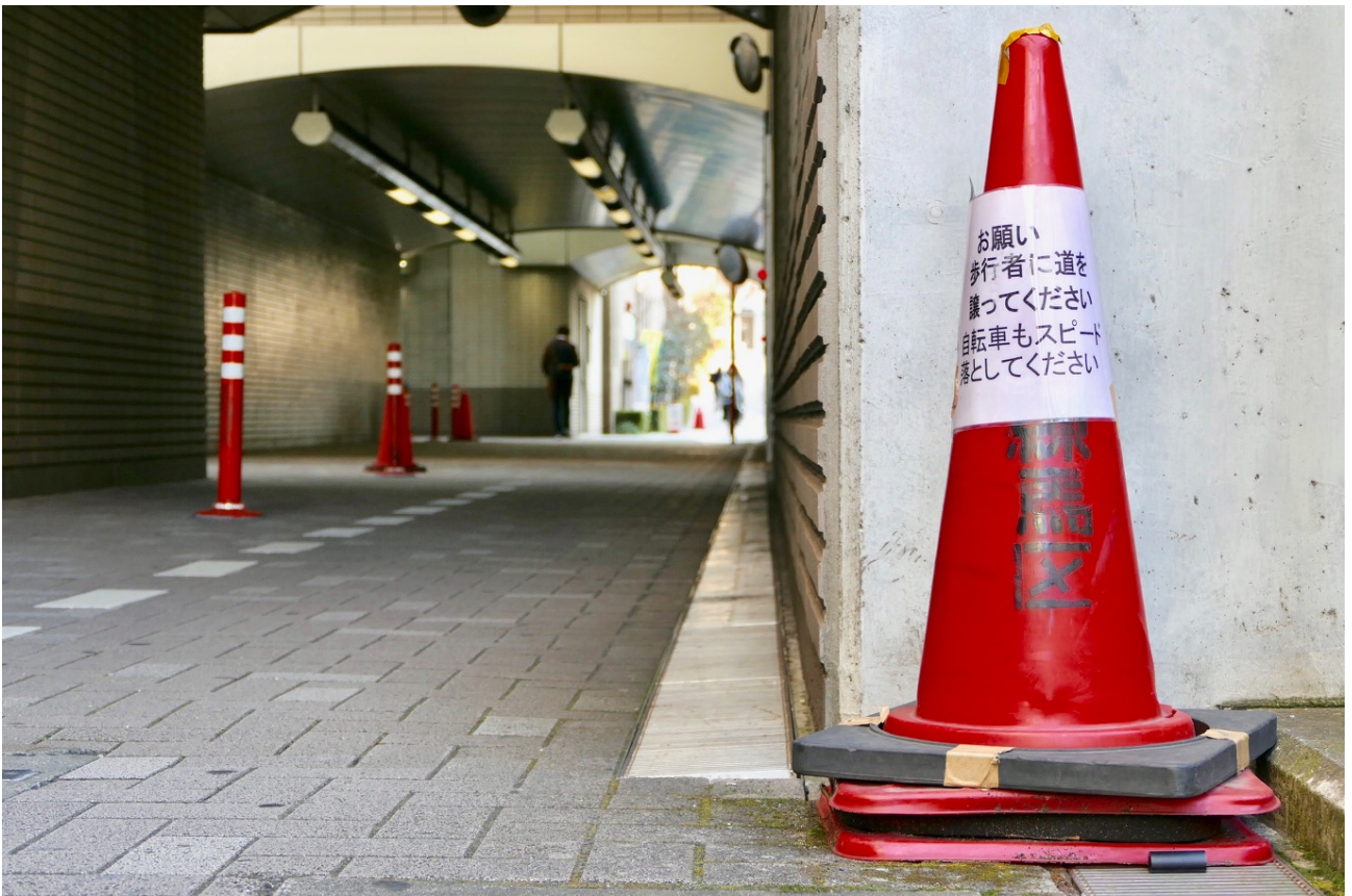
歩行者と自転車を空間分離していないにも関わらず斜路は10% (現地での実測値)。撮影日・場所は同上。
