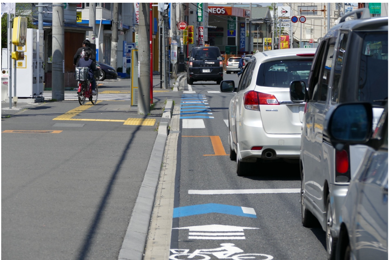
矢羽根の幅がそのまま側方余裕になる。国道17号・さいたま市大宮区大成町で2016年4月に筆者が撮影。
