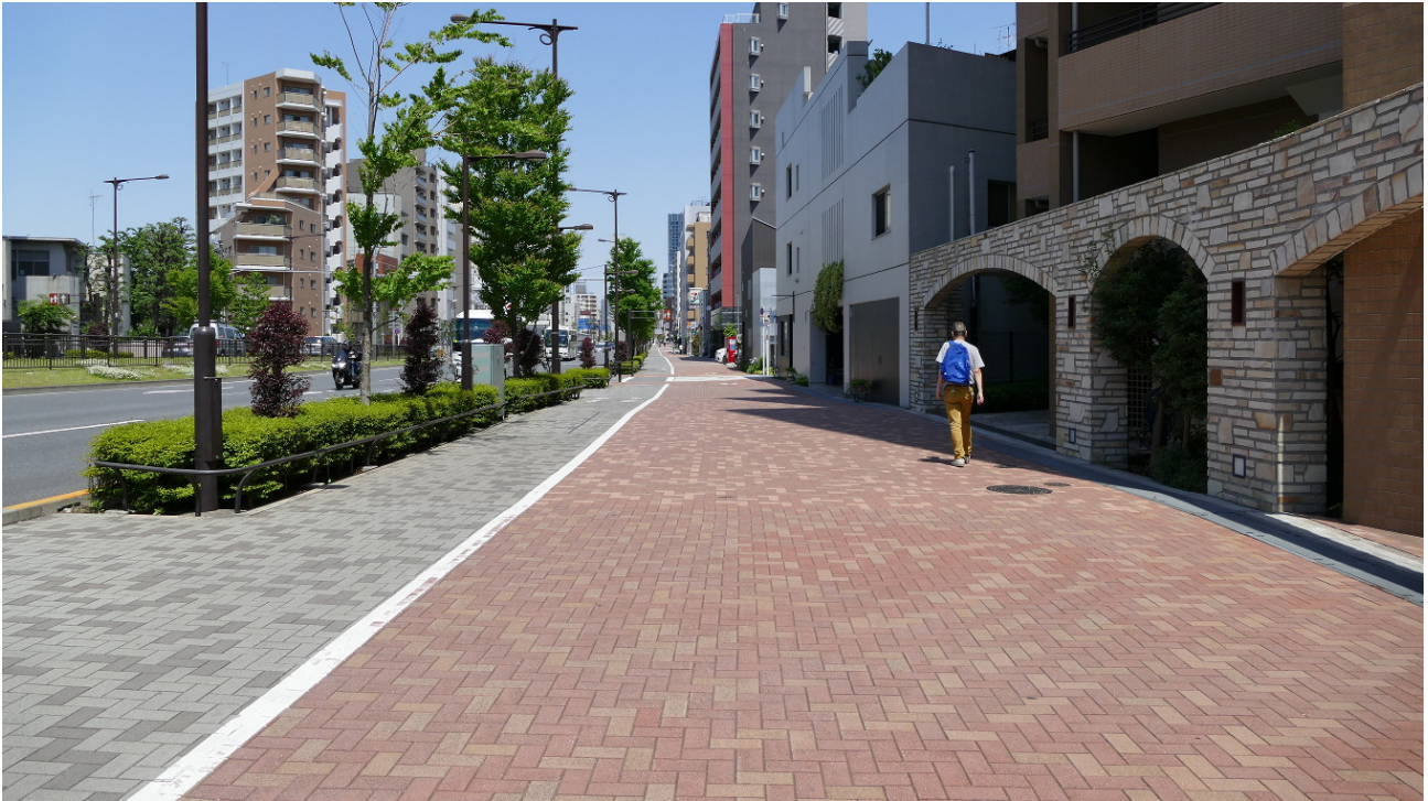
すれ違いも困難な自転車通行空間(左の灰色部分)に対し、不必要に過大な歩行者通行空間(右の煉瓦色部分)。 適切な設計指針が無ければ空間資源を持て余してしまい、効用の最大化ができないのである。 都道317号の長崎一丁目交差点付近で2016年5月に筆者が撮影。
