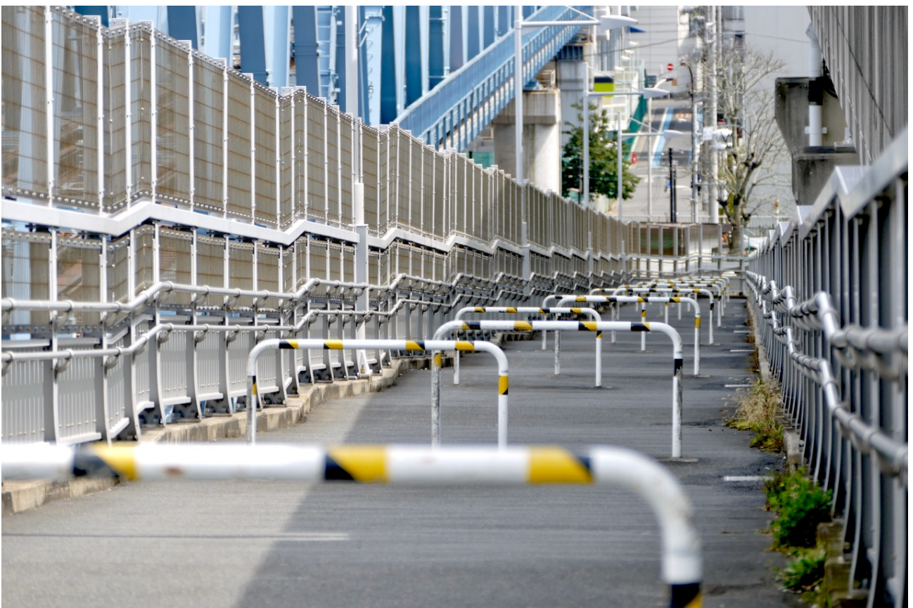
都道10号の清砂大橋東詰め北側歩道の斜路。歩行者と自転車を分離せず、車止めで速度を抑えさせている。 2017年4月に筆者が撮影。
