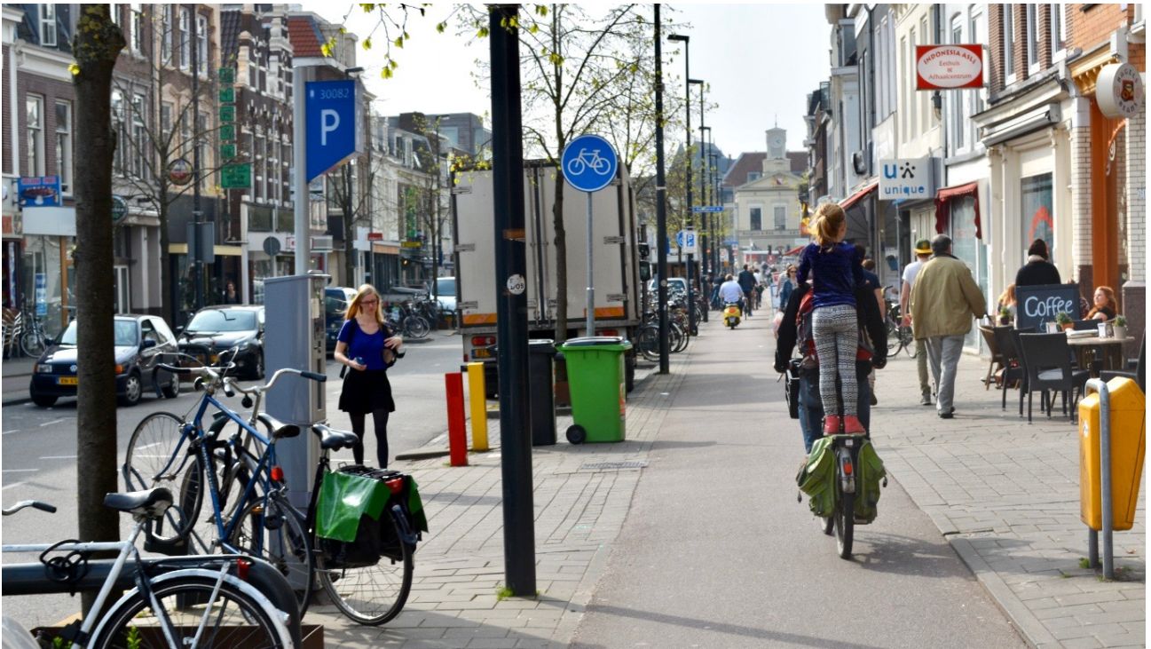
出典：As Easy As Riding A Bike (2014-04-17) ※オリジナル写真に明るさ調整を加えた。 駐輪ラックやパーキングチケット発券機、街路灯、ゴミ箱、標識、路上駐車枠など、あらゆるモジュールが緩衝帯の中に収容されており、道路の交通機能と空間機能を両立させている。
