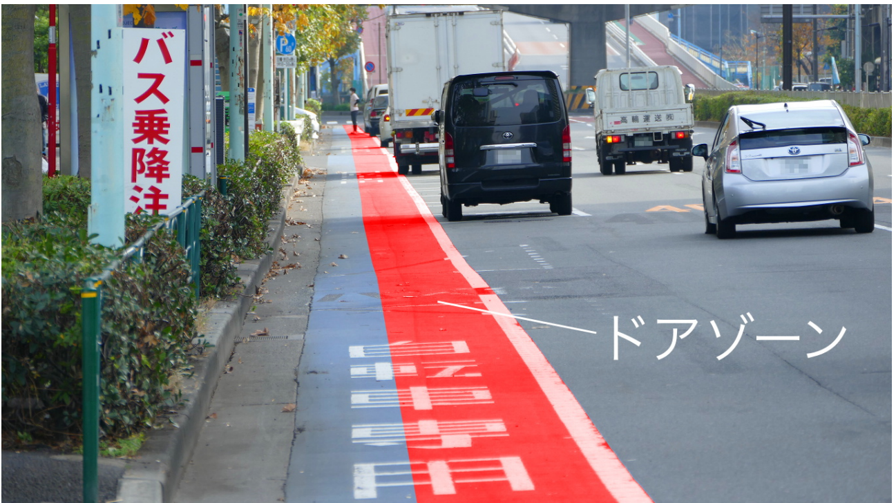
駐車枠寄りの半分以上が路駐車両のドアとの衝突リスクが高い「ドアゾーン」と重なっている。 しかし、自転車レーンを車道中央側に配置した場合でもドアゾーンと重なっていればドア衝突リスクは無くならない。 上2枚とも都道480号・港南三丁目交差点から2016年12月に筆者が撮影・加工
