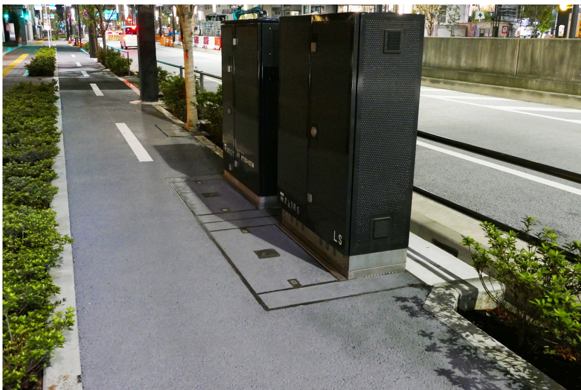
都道 405 号の新橋付近の自転車道。共同溝の地上機器、街路樹などが通行空間を侵食している。 2016 年 9 月に筆者が撮影。
