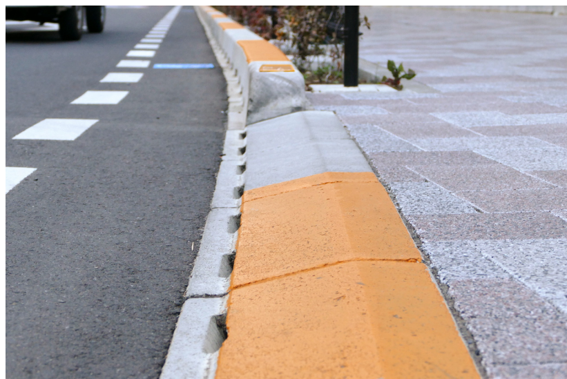
同じく failproof なスロープ形状の縁石。武蔵野市中町一丁目27番で2017年2月に筆者が撮影。
