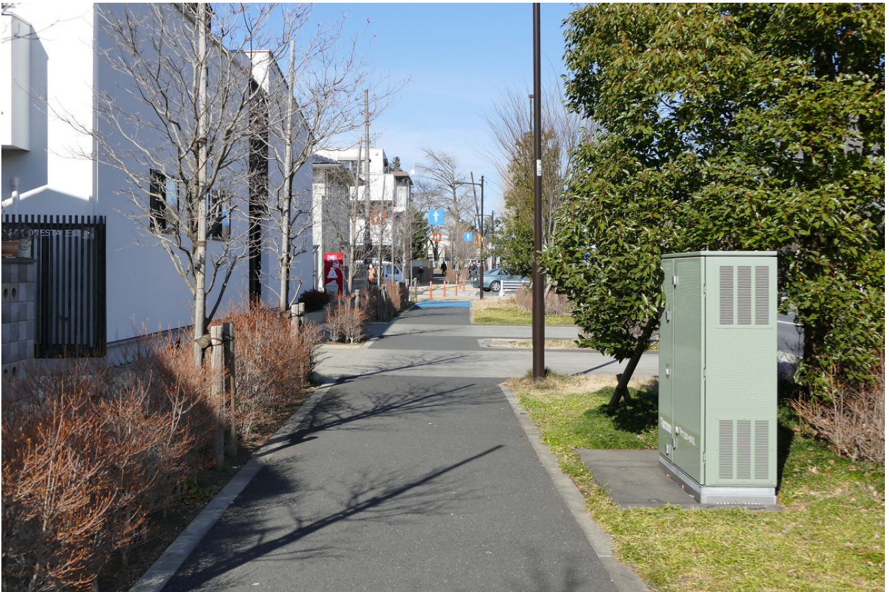
共同溝の地上機器が自転車通行空間の建築限界に対して充分余裕のある位置に配置されている。これと同じ配慮が植栽の配置にも必要である。都道12号(新武蔵境通り)の境浄水場付近で2017年2月に筆者が撮影。
