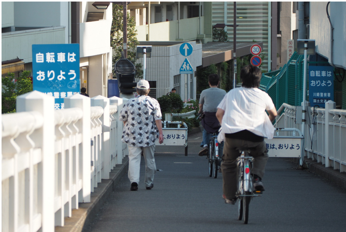
国道 15 号の六郷橋の自転車歩行者道。斜路は車道より急勾配だが歩行者と自転車は分離されていない。2015 年 5 月に筆者が撮影。
