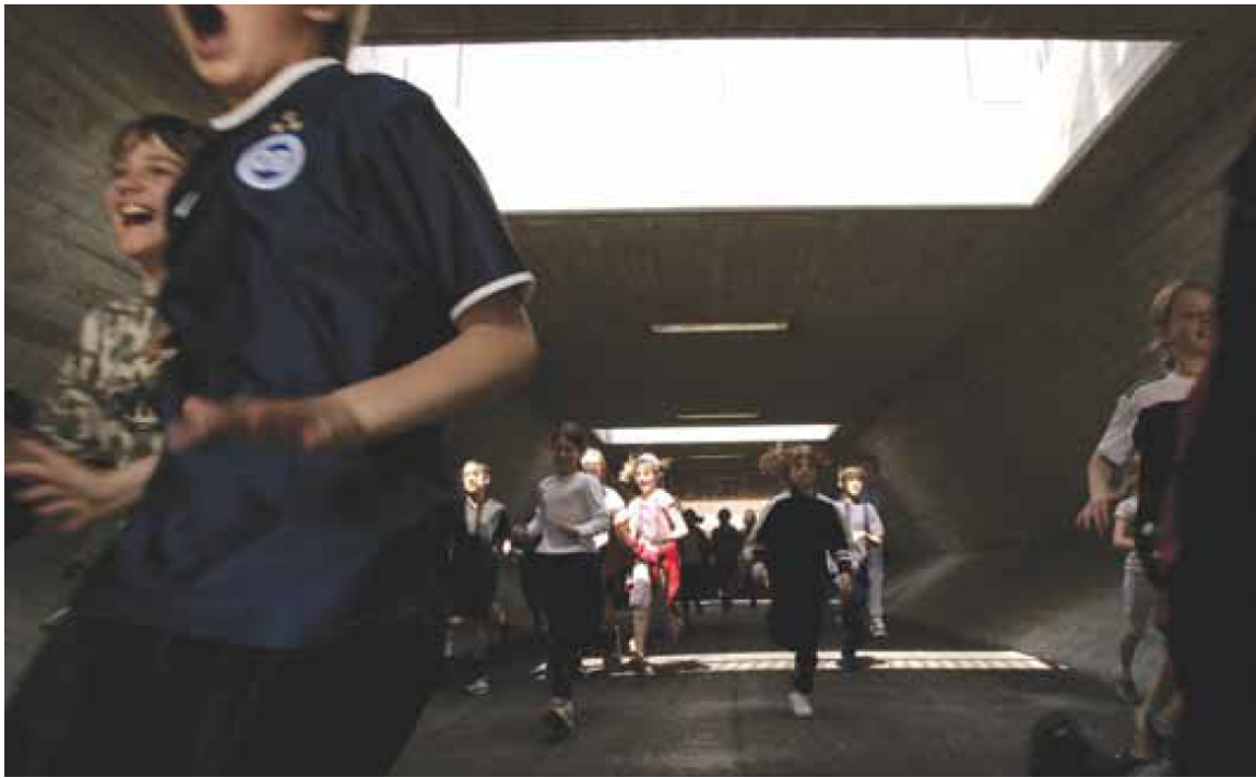
Søren Underlien Jensen et al. (2000) の内容に独自の改良案を加えた Troels Andersen et al. (2012) が例示した望ましい自転車用トンネル構造。壁を後退させたダイヤモンド型の断面形状や天井の採光窓で、閉所感・圧迫感を緩和している。 出典：Troels Andersen et al. (2012, p.102)
