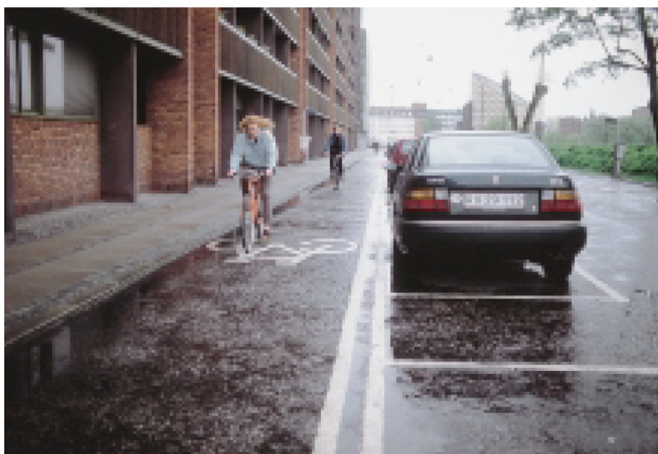
駐車枠よりも歩道側に配置された逆行自転車レーン。幅も十分広い。出典：Søren Underlien Jensen et al. (2000, p.97)
