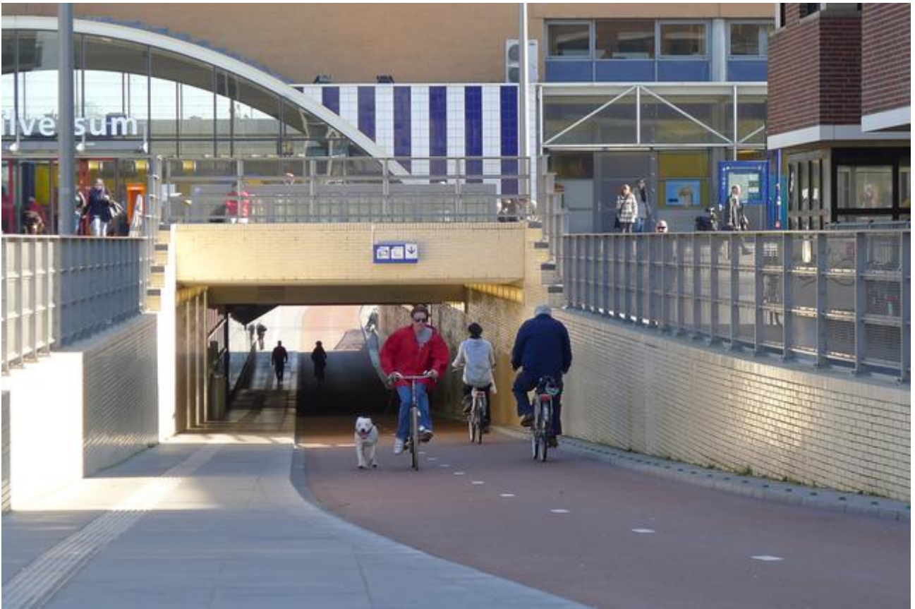
Hilversum 駅のアンダーパス。CROW (2007, p.214) の設計指針を反映し、歩行者と自転車それぞれに専用の通行空間が用意され、トンネル内は直線で視距が長く、安全にスピードが出せる。見通しの良さは閉所感の緩和や防犯の意味でも重要である。 出典：London Cycling Campaign (Go Dutch Gallery)
