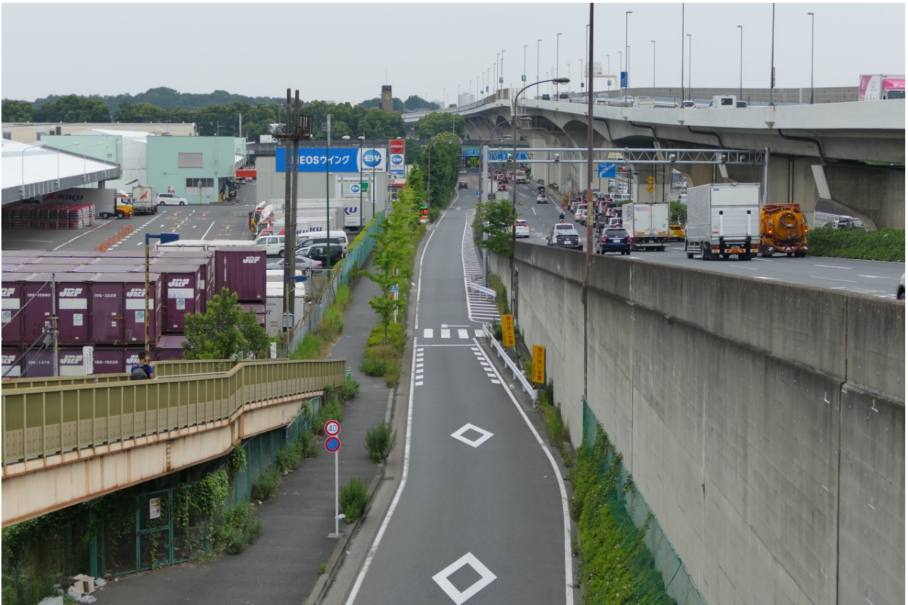
国道17号の笹目橋南詰め東側の斜路。歩道橋の縦断勾配は車道の倍の10%と急だが歩行者と自転車が分離されていない。歩道橋を降りた先の歩道も狭く、車止め設置前は自転車と歩行者の衝突の危険性が高かった。2016年5月に筆者が撮影。
