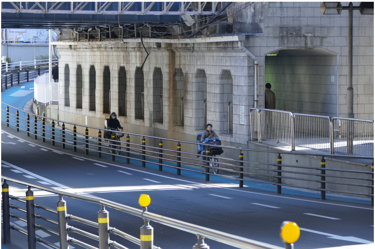
自転車道の路面が隣の歩行者通路より1メートル以上低い。自転車にとっては空頭が過剰である。2017年2月に筆者が撮影。
