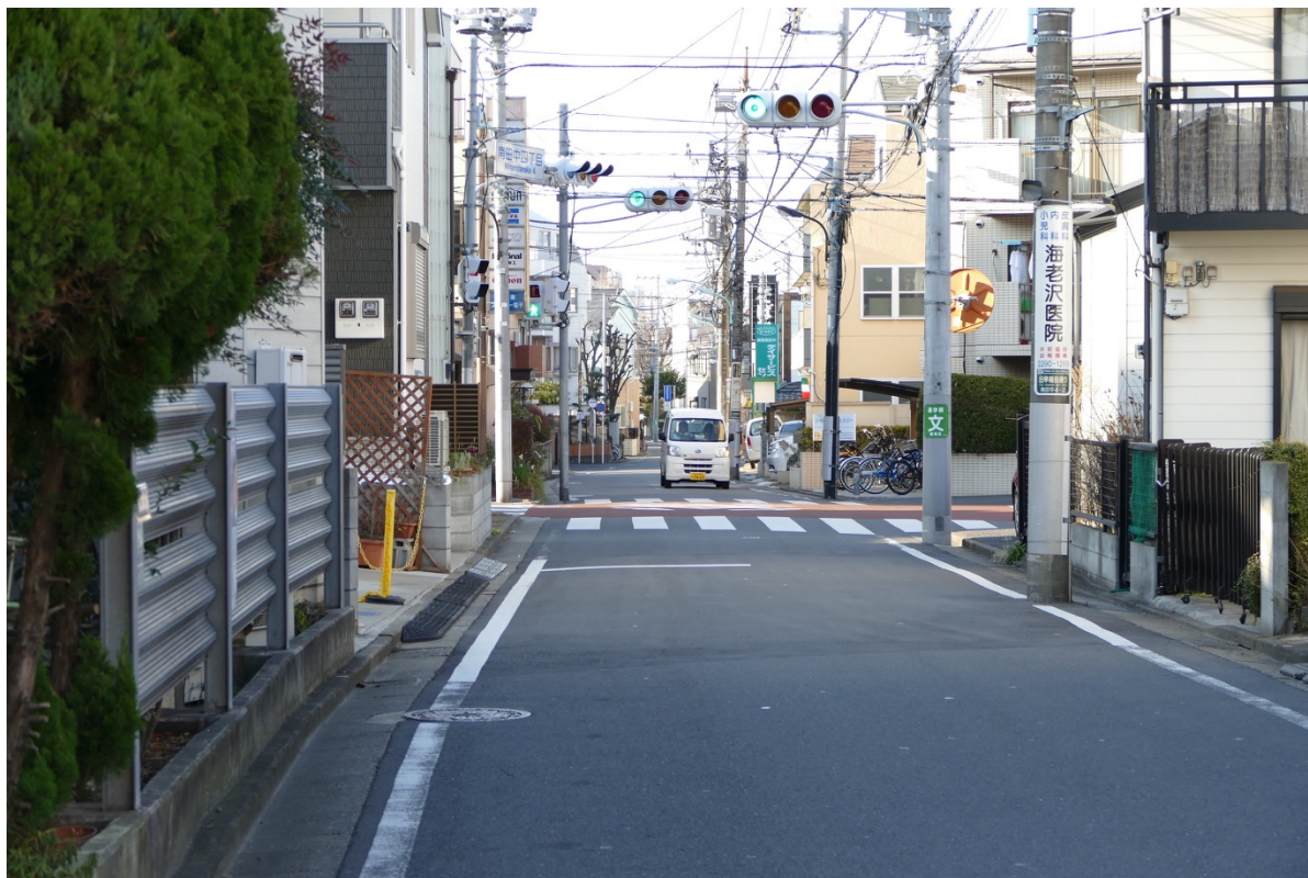
車道外側線が街渠エプロンのすぐ近くに引かれた例。練馬区南田中で2017年1月に筆者が撮影。
