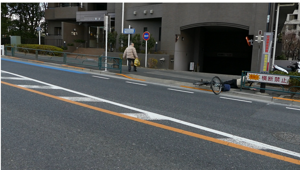
車道を行っていた自転車利用者はレーン終端部の車両乗り入れ部から歩道に上がろうとして転倒した。同じく筆者撮影。
