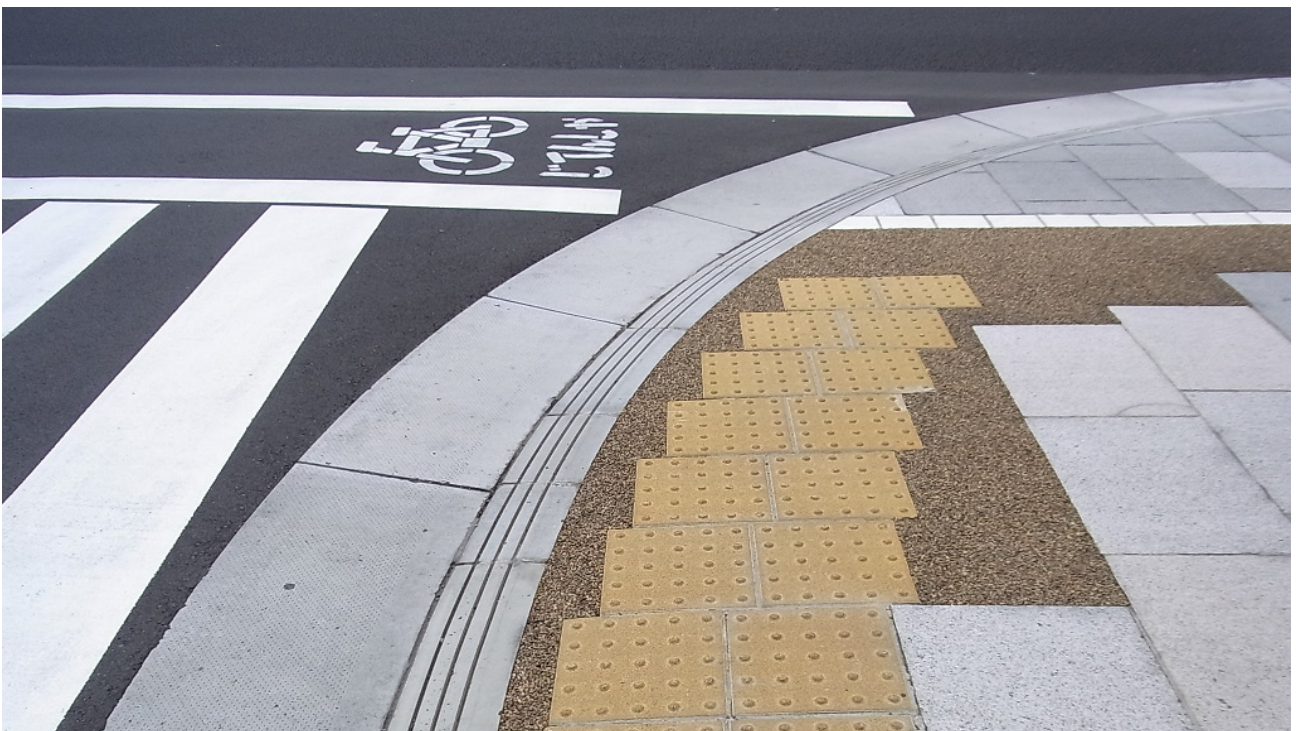
段差を極力小さくしたスロープ断面の縁石。都道463号で2014年7月に筆者が撮影。
