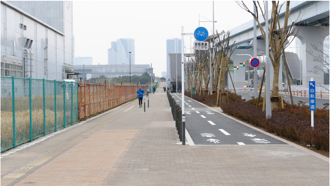
歩道の一部をアスファルトで滑らかに舗装し、自転車道とした事例も存在する。 都道484号・有明コロシアム付近で2017年3月に筆者が撮影。
